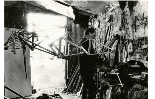
1969年、ロンドンの作業場にて従来の金属加工技術と電子工学を使い、実験するエドワード・イナトビッチ
