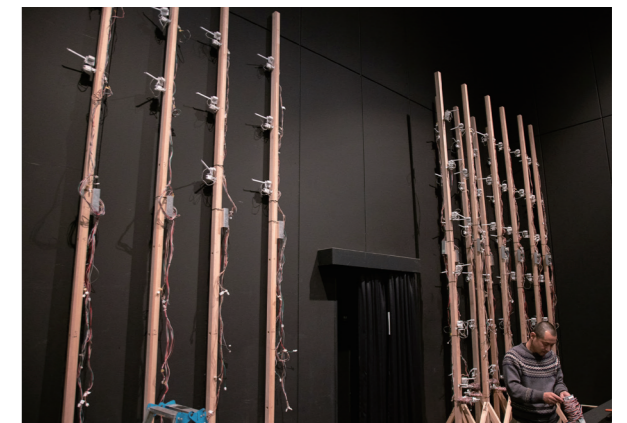
メンテナンス用の列柱に取り付けられた「蠢く壁面」のサーボモーター Servomotors mounted on each maintenance colonnade.
