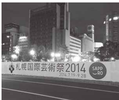
工事現場仮囲い [大通西4丁目]
