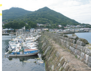
3. 函館港改良工事
