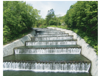
2. 奥沢水源地下水道施設
